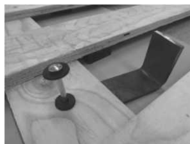
Kotevní čep poté zatlučte kladivem na požadované místo.
