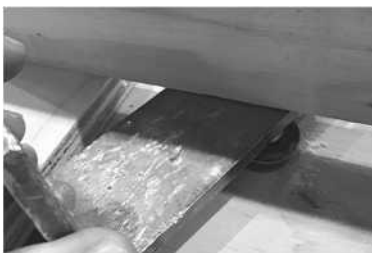
Blok může projít mezerou mezi hlavou kotevního čepu a panelem umístěným na horních latích.
