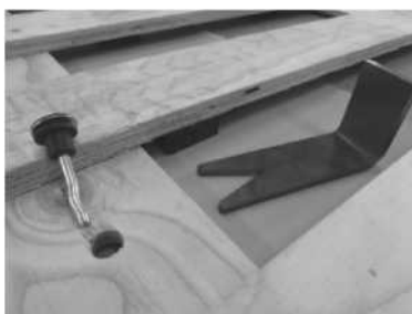
Tento klín umístěte pod lať ještě před zatlučením kotevního čepu.
